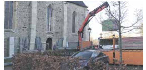
Abtransport der Gerüste in der letzten Woche
